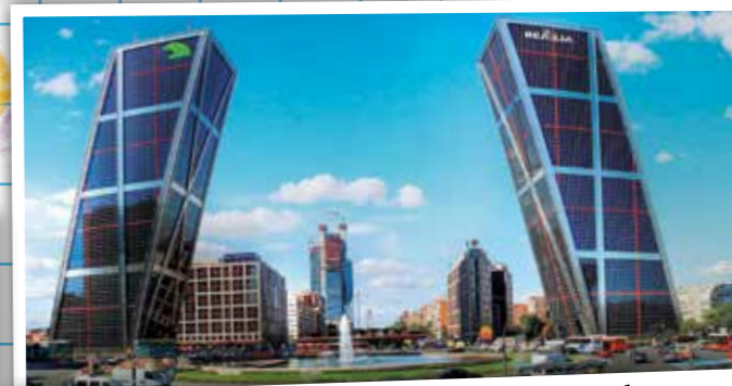
Ворота _____ – 114-метрові вежі-близнюки в Мадриді. Кожна будівля має 26 поверхів. Це перші у світі похилі хмарочоси. В4 Г4 Б4 В1 Г5 В3
